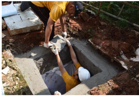
Gambar 8. Memasukkan Batu kali ke Dalam Sumur Resapan
