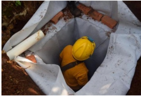
Gambar 5. Pemasangan Geotekstil
