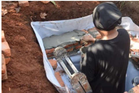
Gambar 6. Pemasangan Batu Bata
