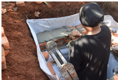
Gambar 6. Pemasangan Batu Bata
