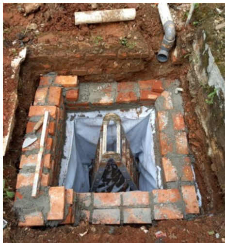
Gambar 7. Pembuatan saluran pemasukan dan pembuangan
