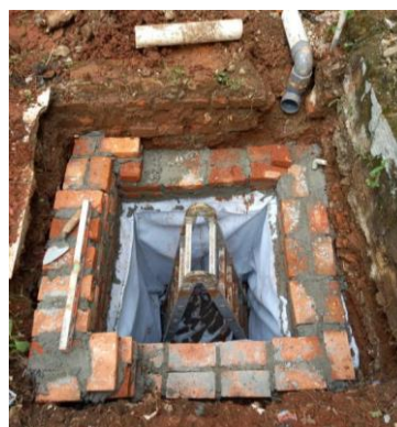
Gambar 7. Pembuatan saluran pemasukan dan pembuangan
