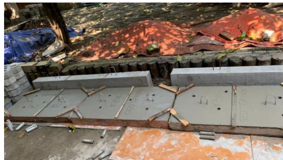
Gambar 2. Pembuatan Tutup Sumur Resapan
