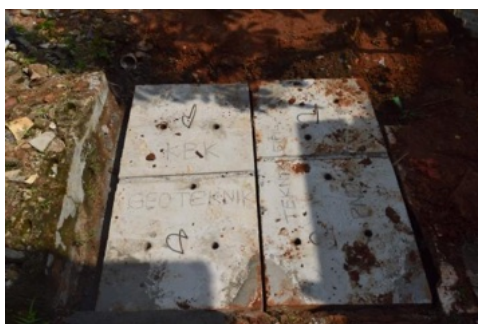
Gambar 9. Pemasangan Tutup Sumur Resapan
