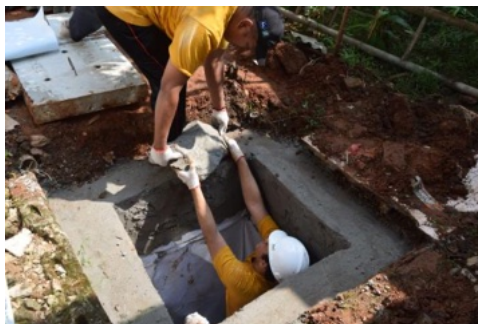
Gambar 8. Memasukkan Batu kali ke Dalam Sumur Resapan
