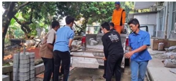
Gambar 3. Membawa Tutup Sumur Resapan ke Lokasi
