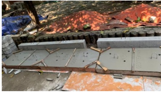
Gambar 2. Pembuatan Tutup Sumur Resapan
