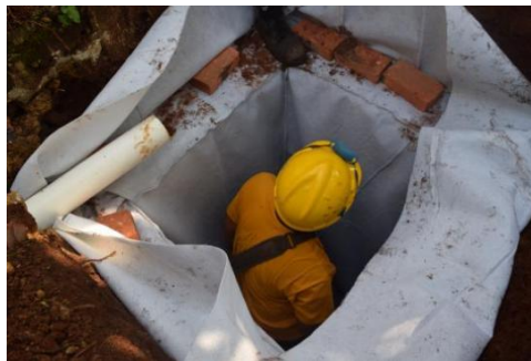
Gambar 5. Pemasangan Geotekstil
