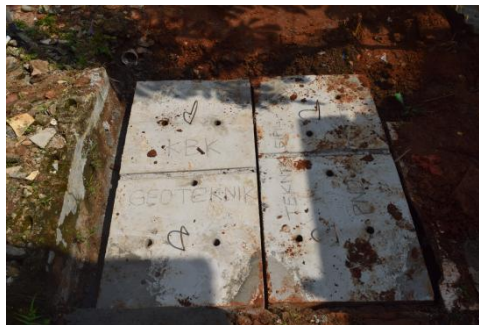
Gambar 9. Pemasangan Tutup Sumur Resapan
